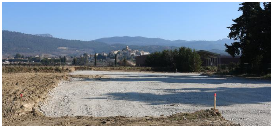
Les travaux ont débuté en novembre dernier.
