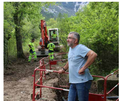
Cyril Berthet, 1er Adjoint de Saint-Léger-du-Ventoux, suit le chantier du réseau d'eau potable.
