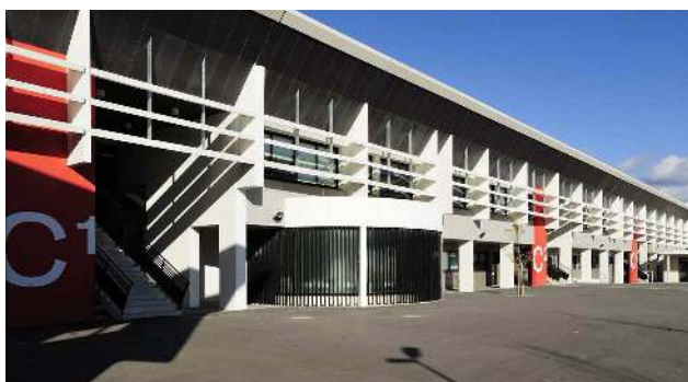
La cité mixte Haute Qualité Environnementale de Vaison-la-Romaine: - un collège - un lycée - un gymnase - une cantine - un internat - des logements de fonction © Jérôme Siame
