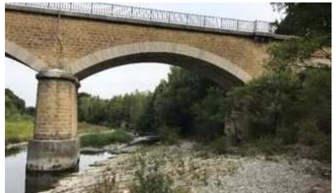
Ouvrage franchissant l'Ouvèze et Ambroisie
