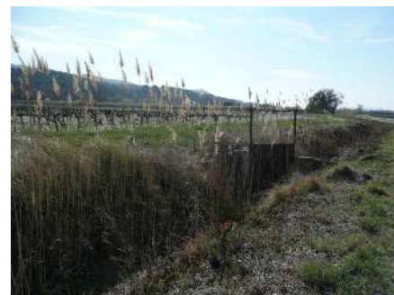
Réseau collectif de l'ASCO du canal du Moulin de Villedieu
