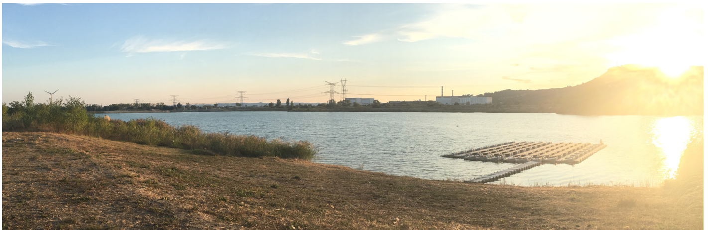
Exemple de développement de panneaux photovoltaïques flottant sur une ancienne carrière à Piolenc ©AURAV
