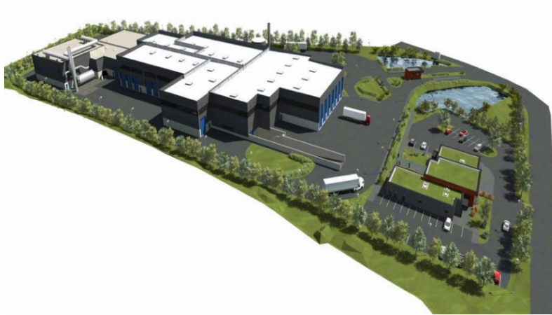
Figure 1 : Centre de préparation de combustibles SYPROVAL
